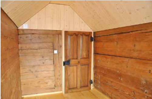
Im Dachzimmer blieb die Originaltüre erhalten.
