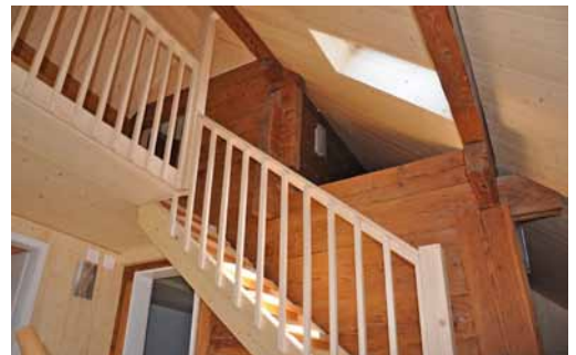
Die alten Balken im Dachgeschoss konnten erhalten werden, die Treppe in Holz neu gebaut.
