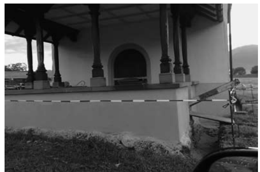
Die neu erstellten Sickerleitungen
