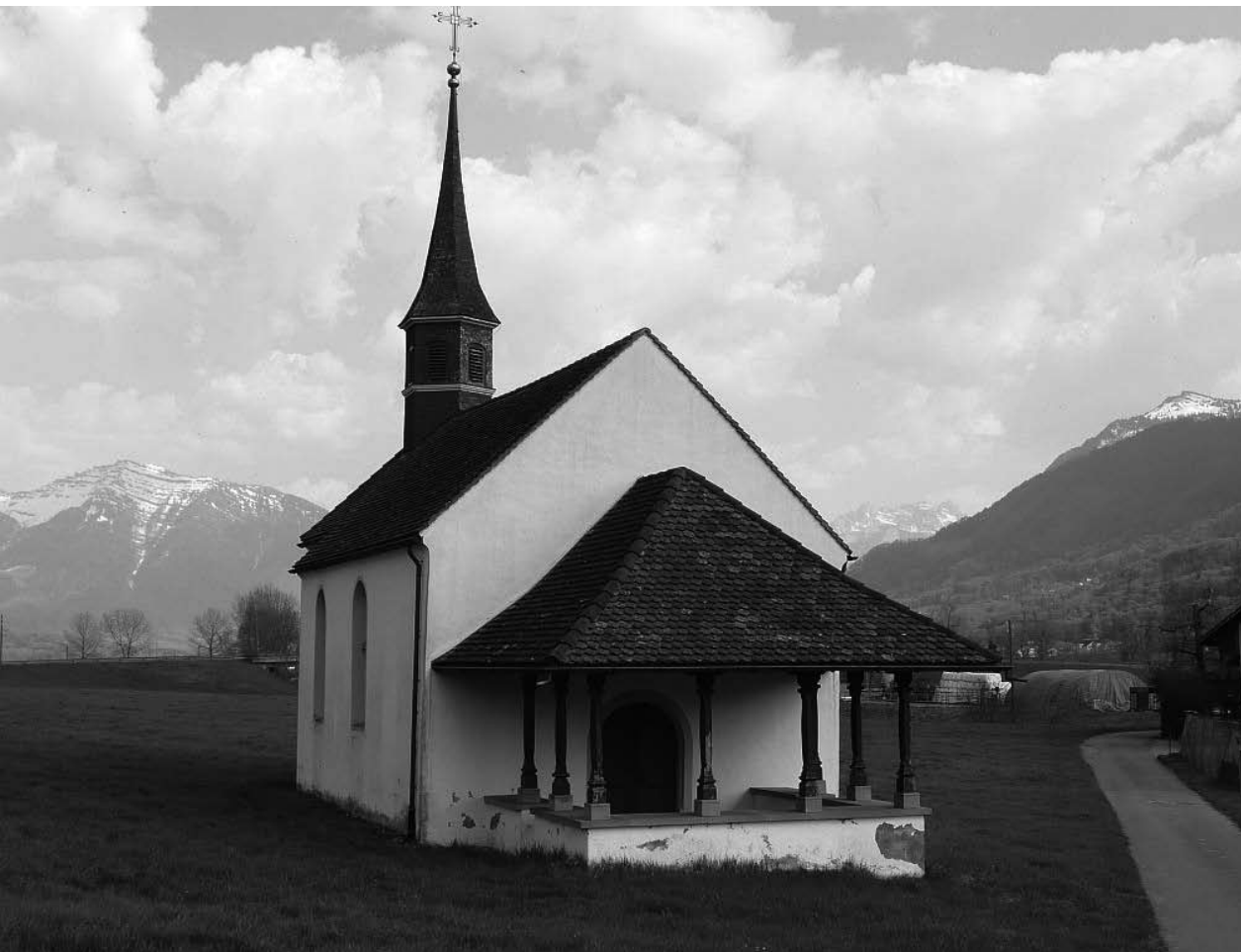
Die Mülener Kapelle vor der Renovation
